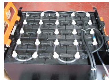
【取付完了】 取付作業:約15分
